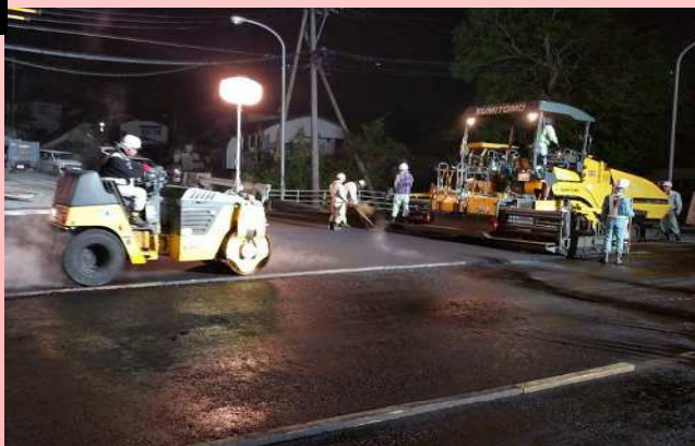
【通行不能の交差点での応急工事】 (国道443号寺迫(益城町))
