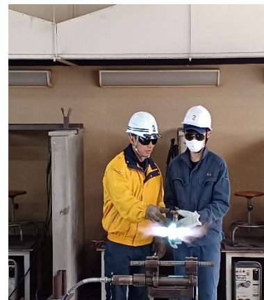
鉄筋ガス圧接
