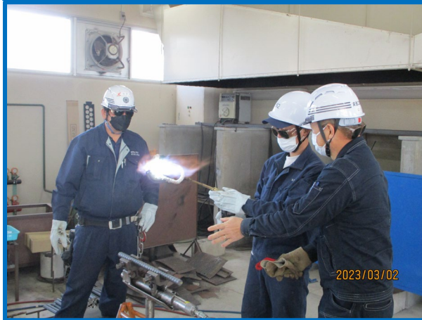
鉄筋・ガス圧接
