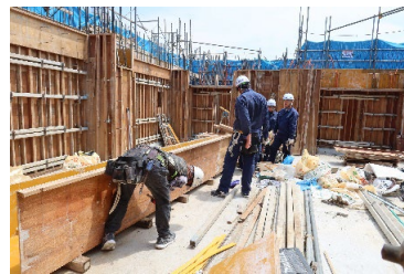
梁側釘打ち体験
