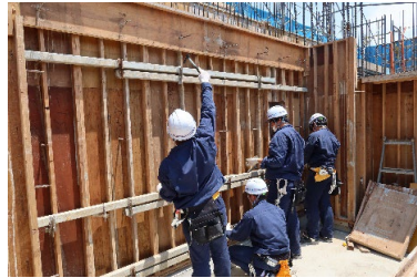
鋼管締め付け体験
