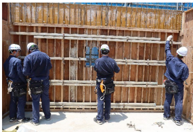
鋼管締め付け体験
