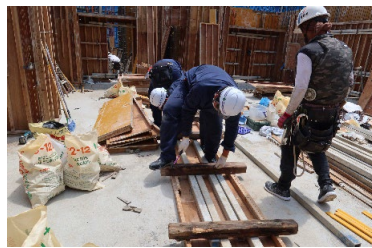
梁側釘打ち体験
