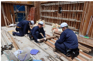
梁側釘打ち体験
