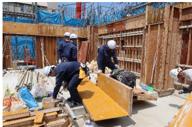
梁側釘打ち体験
