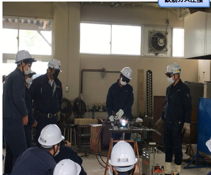
鉄筋ガス圧接
