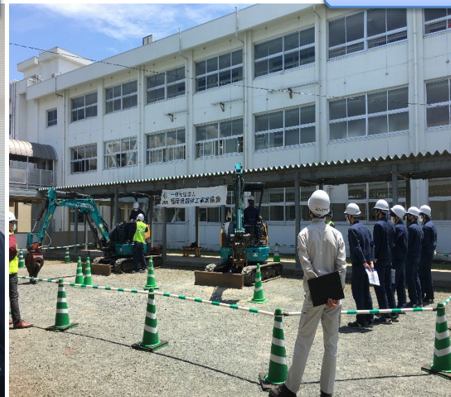
解体重機操作
